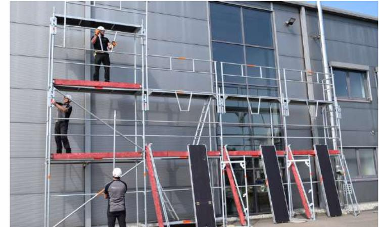
**Bild 1 - Beispiel vertikaler Handtransport von Gerüstbauteilen**
